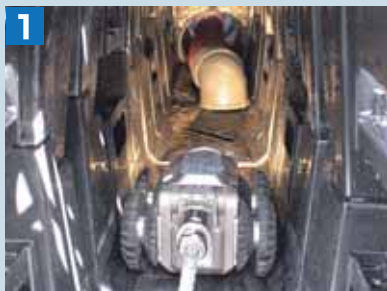
1 自走式カメラによる点検
