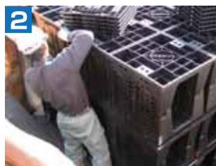
側板の取り付け作業
