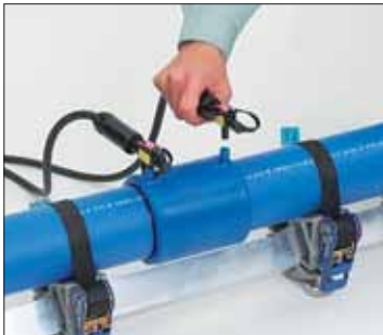
出力ケーブルの接続
